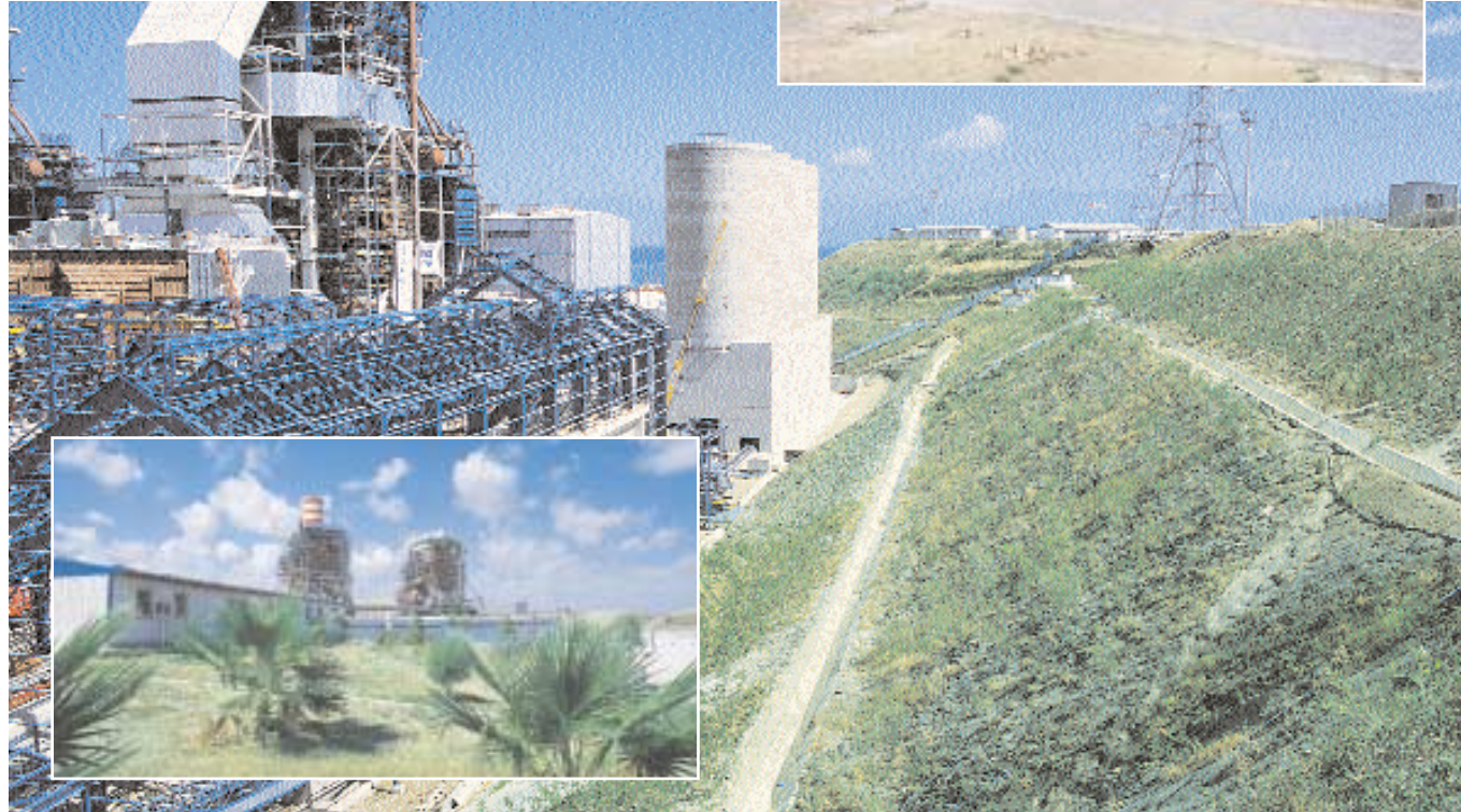
Santral ve çevresi bölgeye özgü ağaçlandırma çalışmalarıyla yeniden düzenleniyor. Farklı bitki türlerinden yüzbinlerce fidan santralla beraber yükselmeye devam ediyor.
